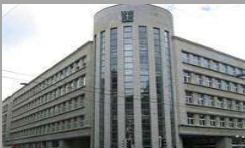
Sanierung (Reconstruction) Alte Börse in Zürich | CH 466 m 2 OKASOLAR
